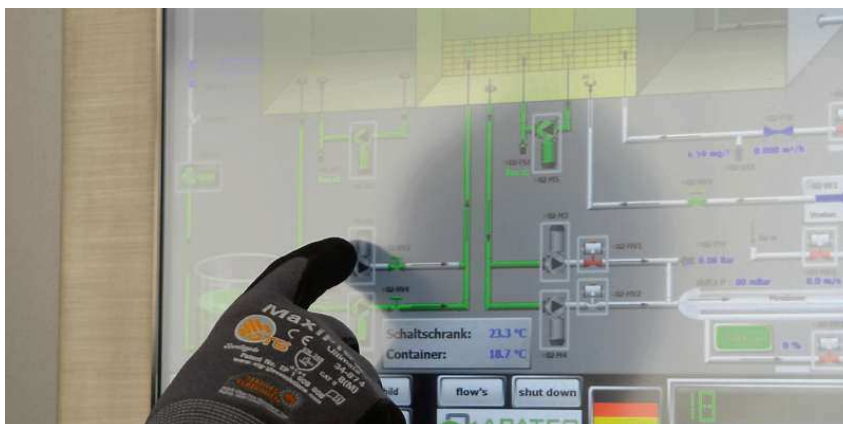
Die Reinigungsanlagen können ferngesteuert betrieben werden
